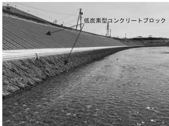
図－6 低炭素型コンクリートブロック活用モデル工事
