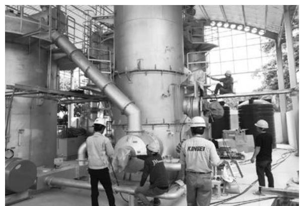
写真－4 ユニット化により工事期間大幅短縮
