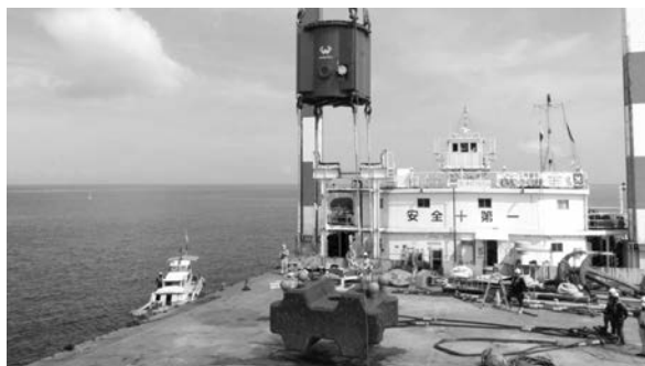
写真－4 施工状況
