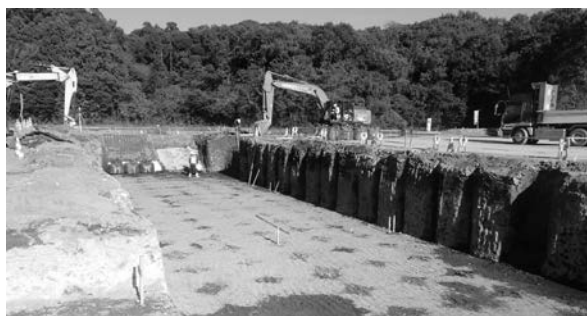
写真－３ 自動打設による改良杭の掘り起こし状況
