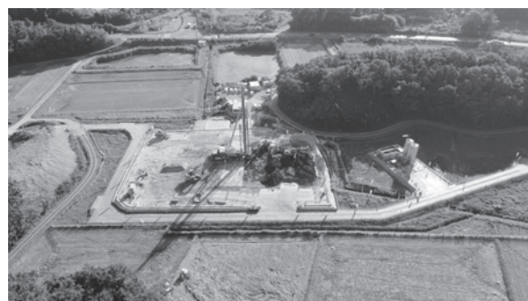
写真－2 施工状況（CI-CMC工法）
