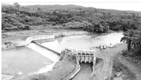
写真－3 トンガル水力発電所 ②取水堰・取水口
