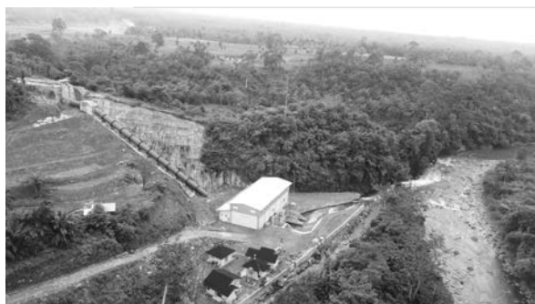
写真－2 トンガル水力発電所 ①全景
