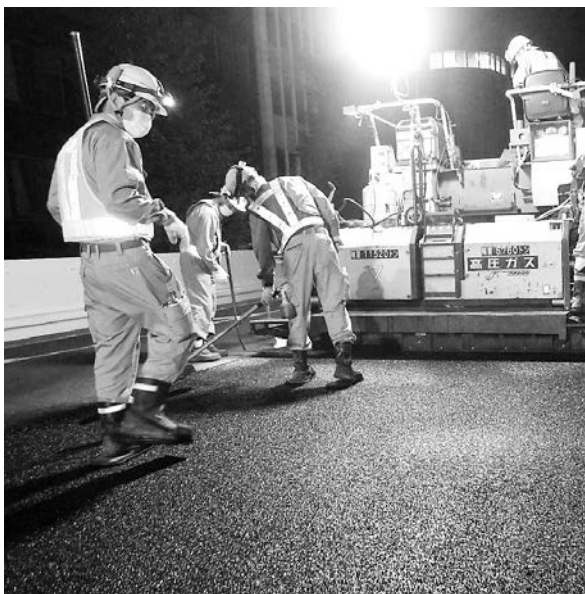
写真-4 高耐久超低騒音舗装施工状況
