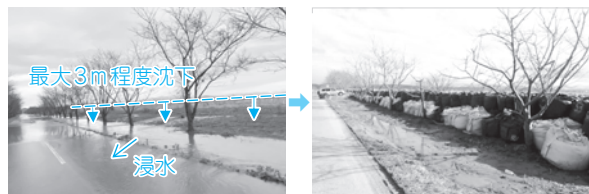
写真－4 堤防のかさ上げ（内灘町 河北潟）
