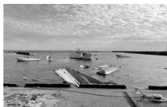
写真－10 津波による防波堤損傷、漁船転覆（飯田港）
