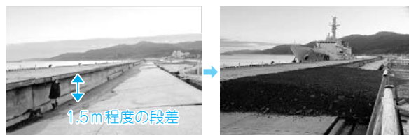
写真－11 ふ頭の段差解消（輪島港マリンタウン）
