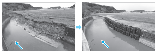
写真－5 護岸の仮復旧（七尾市 崎山川）
