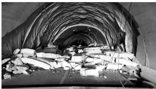
写真－1 道路施設の被災状況（左から県道への落石（珠州市）、トンネルの損傷（珠州市）、液状化（内灘町））
