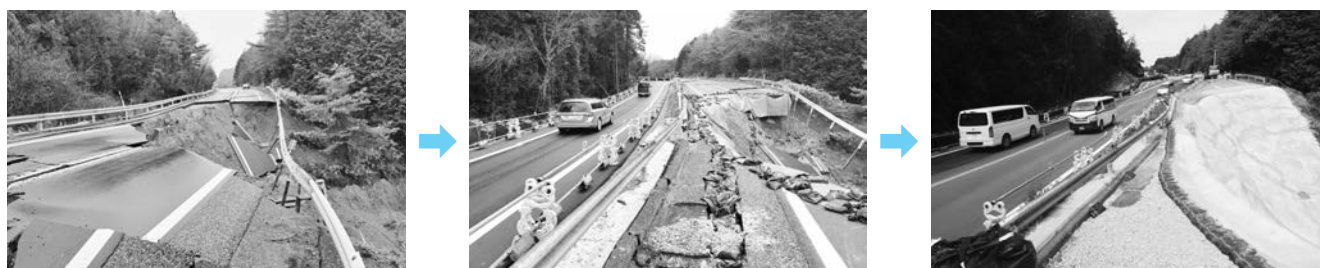
写真－2 のと里山海道の応急復旧状況
