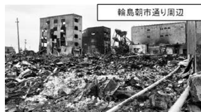
写真－12 火災による被害
