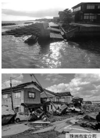
写真－9 津波による被害
