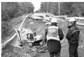
写真-1 建設業者と連携した道路の緊急復旧
