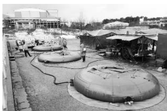
写真-4 自衛隊と連携した仮設風呂への給水活動
