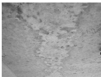
(a) 内部鋼材の腐食の進行を疑うべき外観の変色
