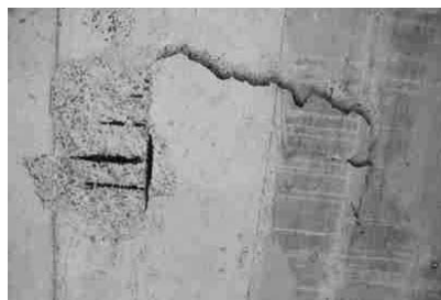
(c) 打音や触診で危険性評価が必要な例
