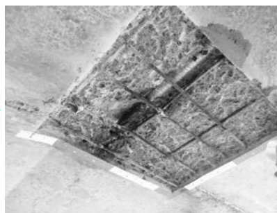
(a) 内部鋼材の腐食の進行を疑うべき外観の変色
