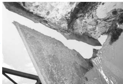
(b) 埋込み部材内部での腐食の進行を疑うべき外観変状
