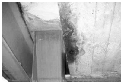
(b) 埋込み部材内部での腐食の進行を疑うべき外観変状
