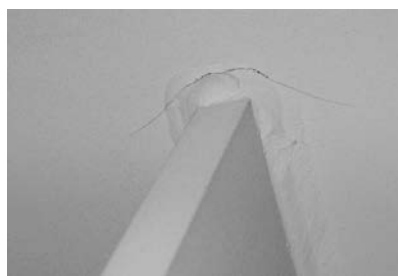
(b) 遠望や画像判読で見落としやすい亀裂
