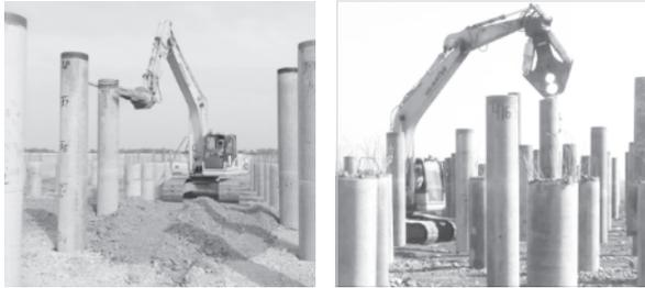
写真-2 大割機「ガジラ」による杭頭処理
