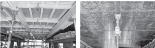
写真-3 パイルドスラブ施工に使用したシステム型枠
