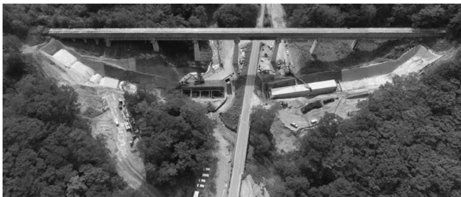
写真－1 施工中全景（既設水路橋解体前）
