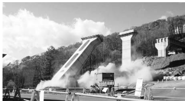
写真－2 既設橋橋脚の発破解体
