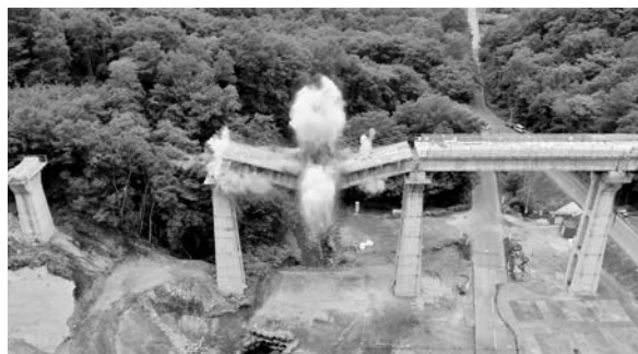
写真－3 既設橋 PC 桁の発破解体
