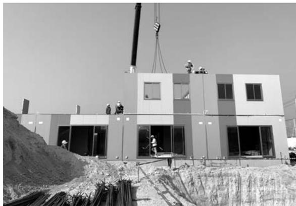
写真-3 SCGハイムの工業化住宅による建築
