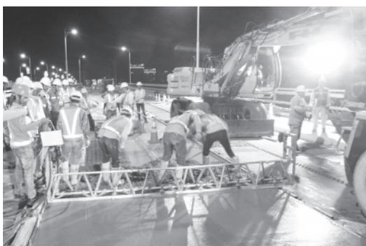
写真－13 SFRC 舗装施工
