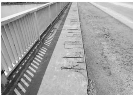
写真－4 着工前：鉄筋が露出した歩道部分
