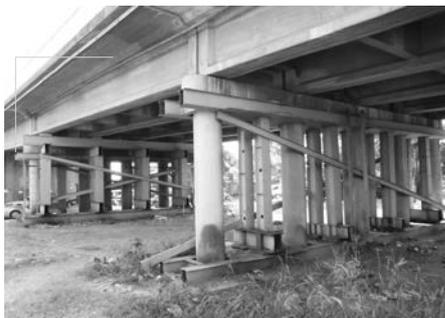
写真－3 着工前：橋脚補強現況
