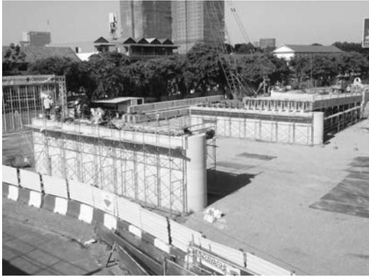
写真－15 PC 桁架設
