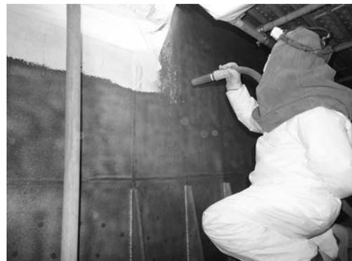
写真-9 ブラスト施工状況
