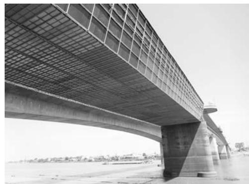
写真-10 パネル式システム吊り足場
