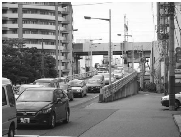
写真－1 混雑状況② 跨線橋
