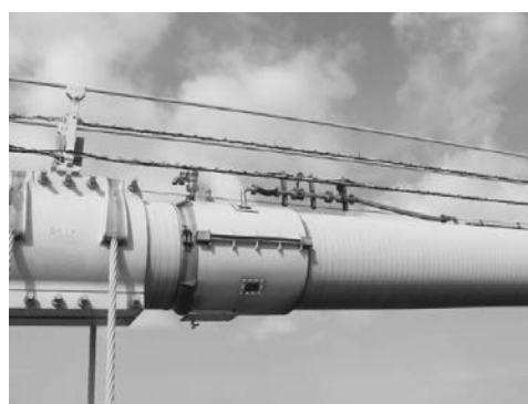
写真-1 吊橋ケーブル送気乾燥システム
