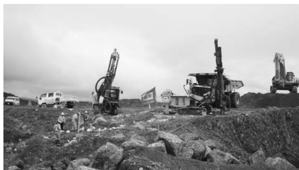
写真－3 硬岩部の掘削状況
