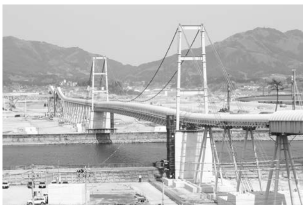
写真－1 土砂搬送用の吊り橋
