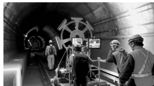
写真－3 ワシントンD.C.の地下鉄トンネル漏水点検状況
