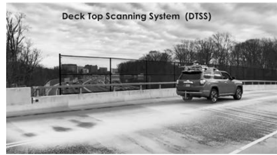
写真－1 赤外線技術による道路橋床版上面点検の状況（イメージ図）
