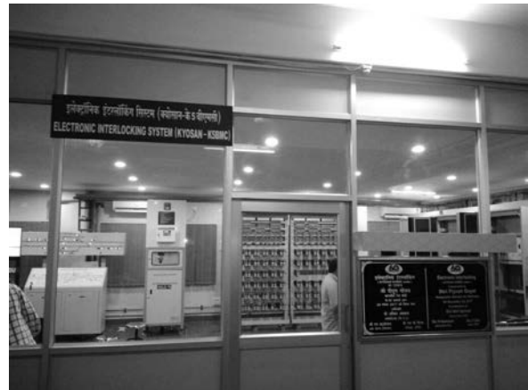
写真－7 IRISSET 京三電子連動装置 専用教室
