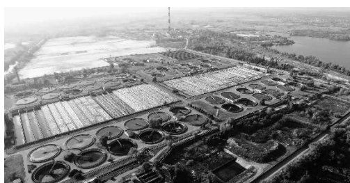
写真－3 ポルトニッチ下水処理場
