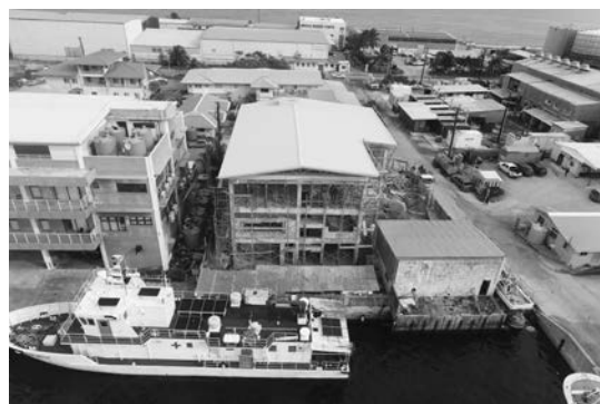
写真－7 マーシャル国 海上保安訓練施設建設
