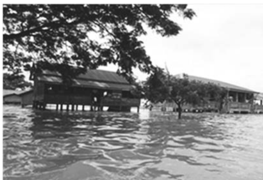
写真-4 ミャンマー国 浸水した学校
