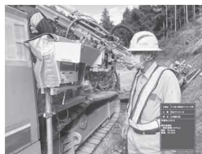
ICT 削孔管理（削孔長）
