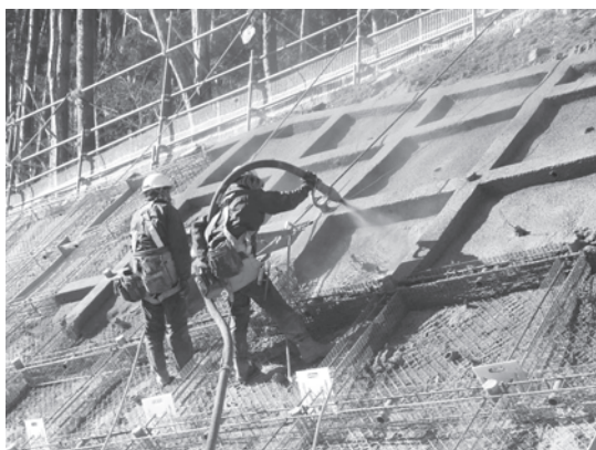
写真-3 法枠工 吹付状況
