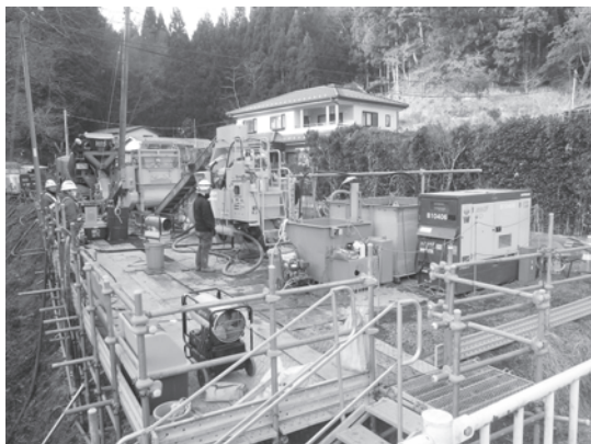
写真-2 Automatic-Shot R 吹付プラント
