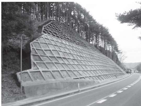
写真-4 工事完成
