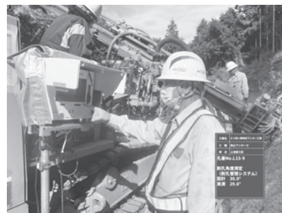
ICT 削孔管理（角度）
