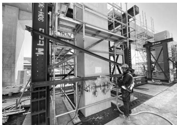
写真－3 PCa 柱部材接合部へのモルタル注入
