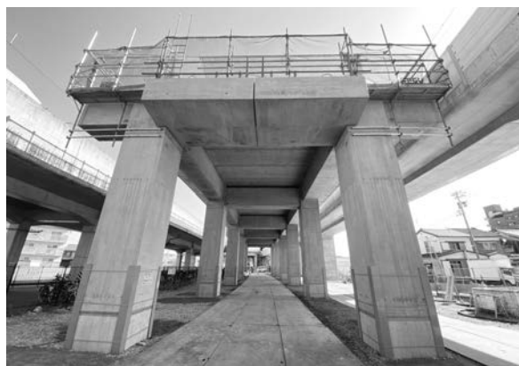
写真－4 PCa 高架橋構築完了
