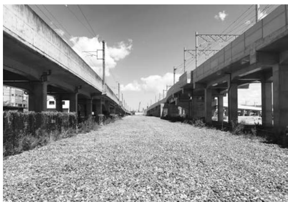
写真－1 営業線近接部の工事着手前（左：JR、右：えち鉄）
