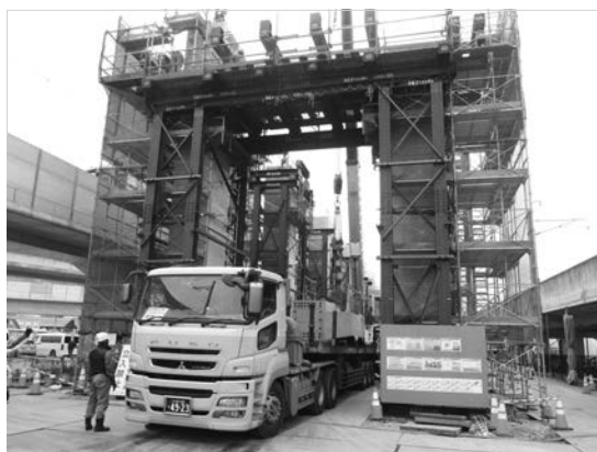
写真－2 PCa 柱部材搬入
