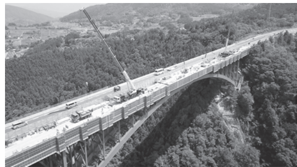
写真－1 床版取替工事の事例
