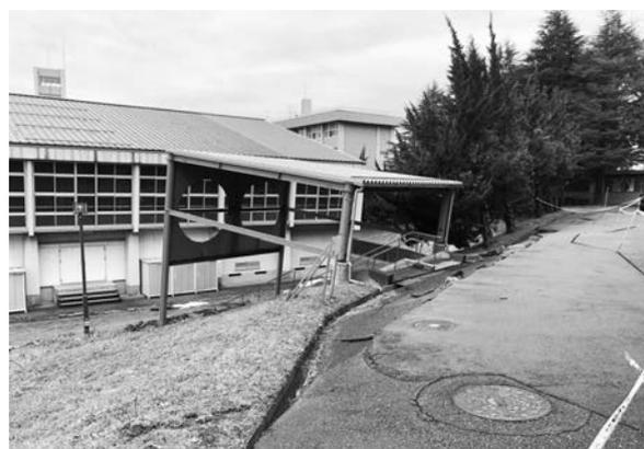
写真-2 のり面のすべり破壊
