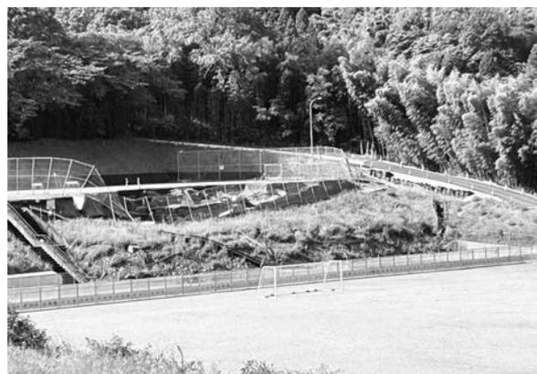
写真-3 のり面のすべり破壊によるテニスコートの崩落
