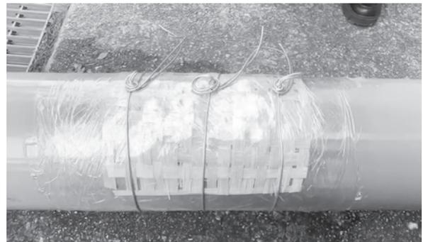
写真-8 竹シートおよびラップフィルムによる損傷箇所の補修状況
