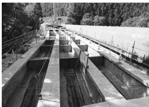
写真－1 既設床版撤去完了
