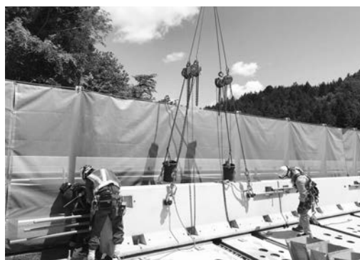
写真－3 フルプレキャスト壁高欄架設状況
