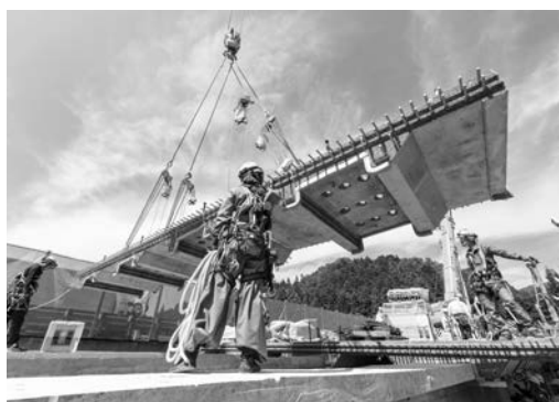
写真－2 プレキャストPC床版「キャップスラブ」架設状況
