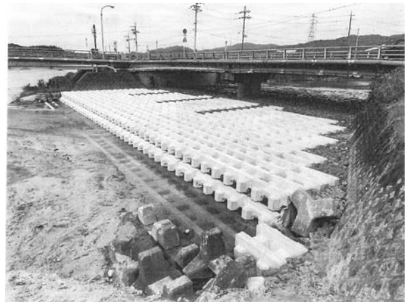
写真-3 工事完了写真
