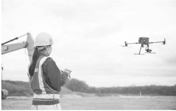
写真-1 UAV 測量
