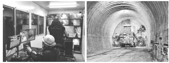
写真－2 遠隔操作による山岳トンネル掘削状況
