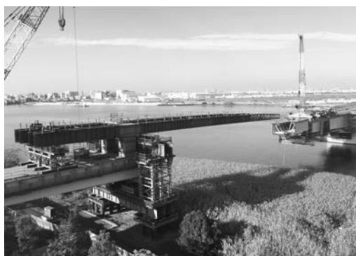
写真－1 送出し架設・張出し架設
