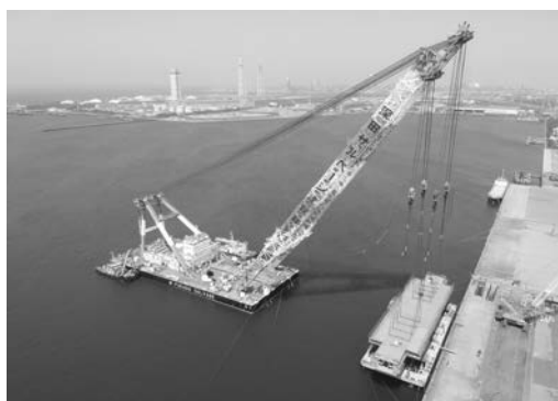
写真－2 大ブロック浜出し
