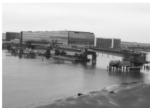
写真－4 一括吊上げ架設
