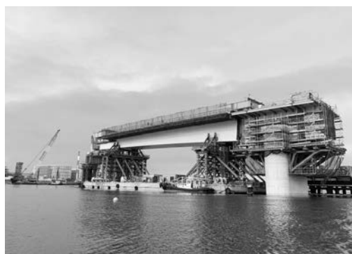
写真－3 台船架設
