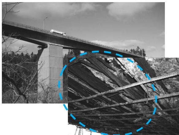
国道18号妙高大橋で発見された鋼材の著しい腐食
