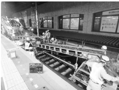
写真-1 ベルトコンベアを使ったバラスト運搬
