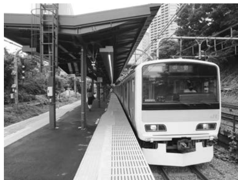
写真-4 直線区間に移設した施工後のホーム（列車とホームの隙間解消）
