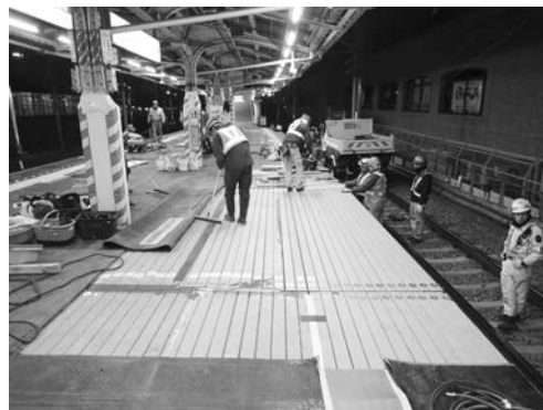
写真-2 ホーム低下に向けホーム面を仮設化
