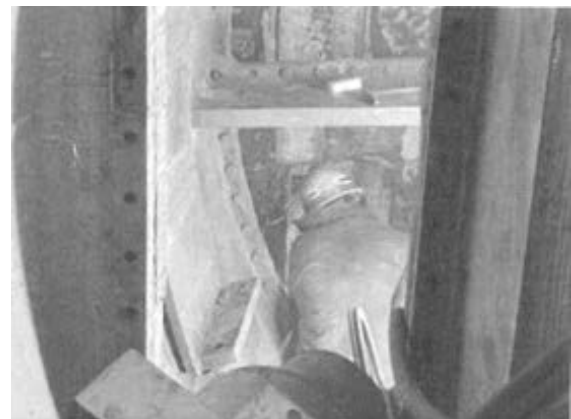
写真-8 シールド機内からの障害物の撤去状況
