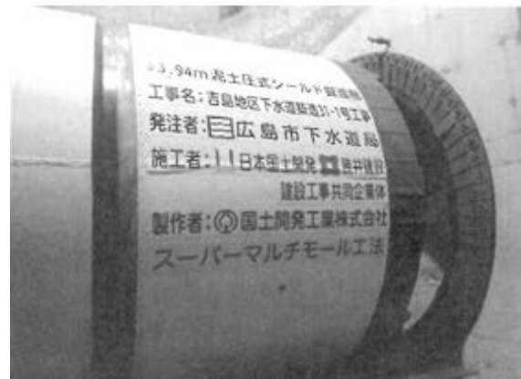
写真-7 シールド機として装備状況
