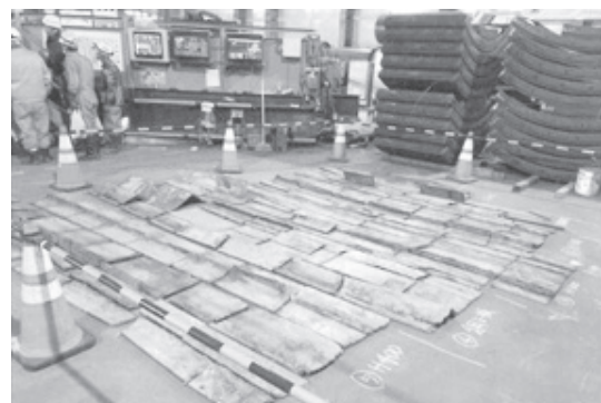
写真-6 鋼材の撤去状況
