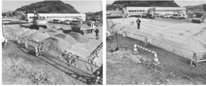
写真-3 実証試験ヤードの状況
