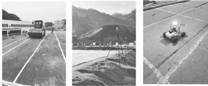
写真-4 次世代 \alpha システムの計測状況
