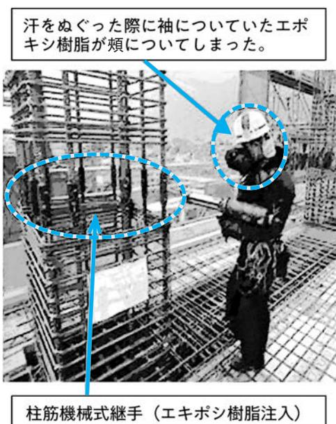
図-2 鉄筋工事における機械式継手エポキシ注入材による皮膚の炎症
