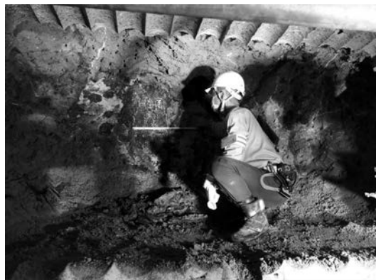
写真－3 南行残置土留め壁確認
