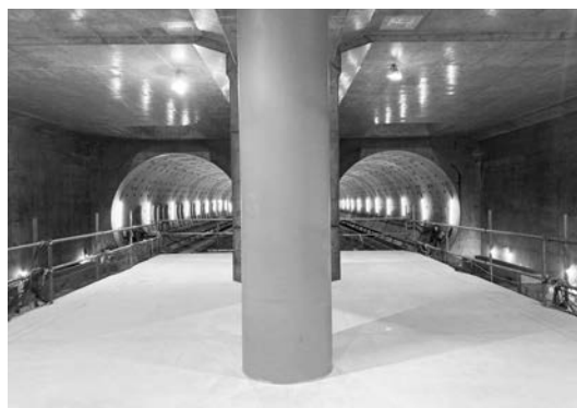
写真－4 掘進後軌道を敷設したトンネル （箕面船場阪大前駅より撮影）
