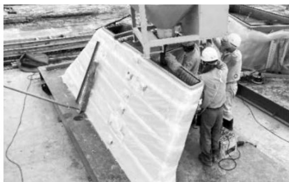
写真-2 常温硬化型 UFC 充填状況
