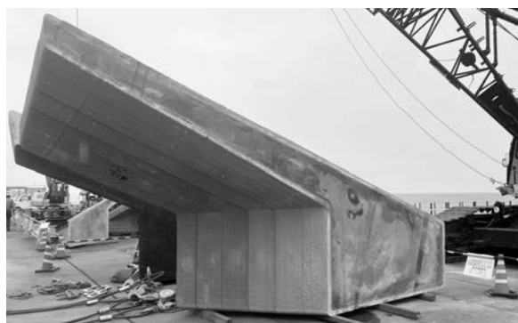
写真-3 3DP ブロック完成状況
