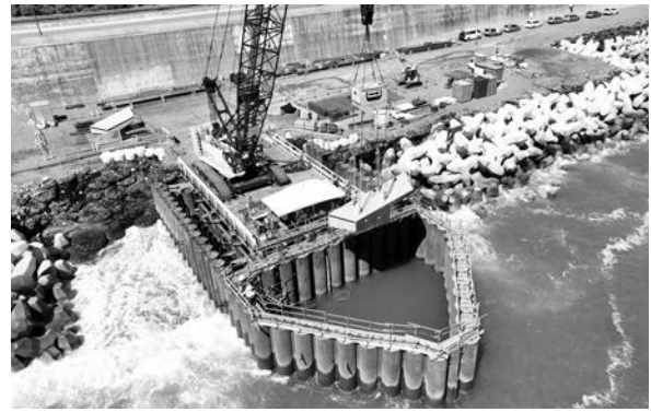
写真-4 3DPブロック据付状況
