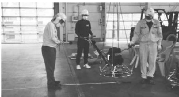
写真－4 電動ハンドトロウエル（モーター）
