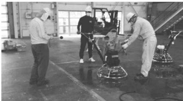
写真－6 電動ハンドトロウエル（モーター）
