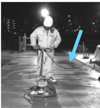
写真－2 配線が必要な電動機械
