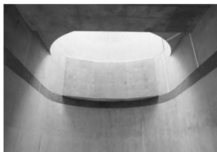
写真－3 換気所地下3階
