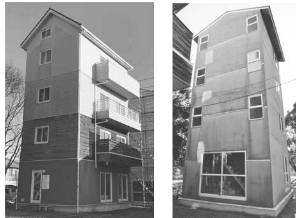
写真-3 4階建て枠組壁工法実験棟 (左:築18年で外壁通気構造, 右:築27年で外壁通気層なし)
