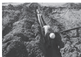
暗渠排水管布設
