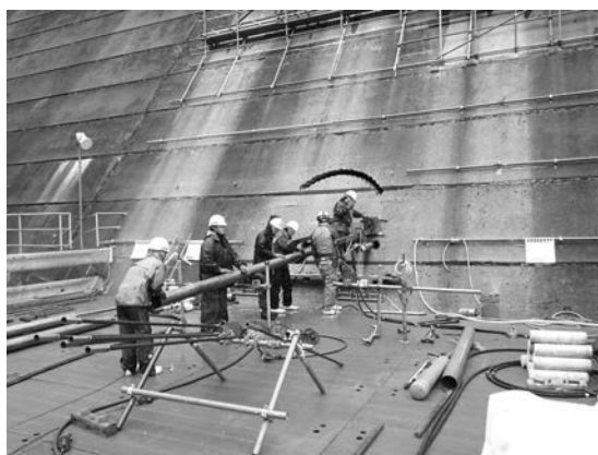
写真-2 上半部削孔状況（スリット作成）
