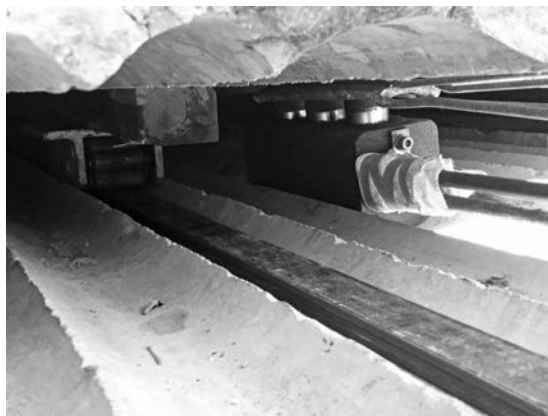
写真-4 上半部割裂状況（バースター工法）
