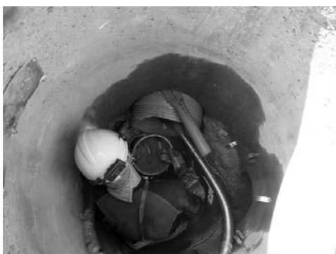
写真-4 注入口取付工の施工状況
