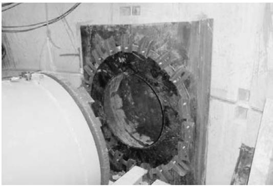
写真－2 坑口工の施工状況
