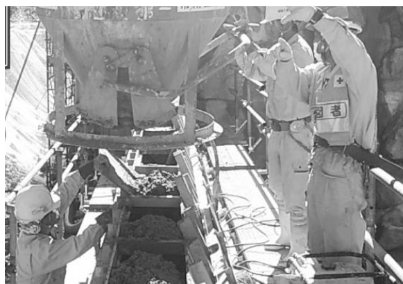
写真-8 コンクリート打設作業状況
