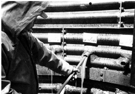
写真-21 孔内洗浄作業状況 (井内作業)
