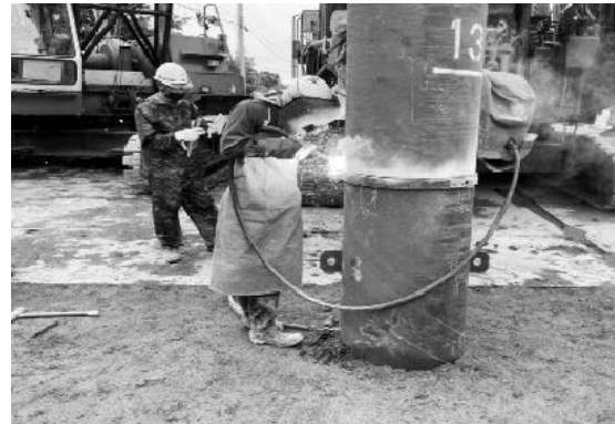
写真-17 継手溶接作業状況
