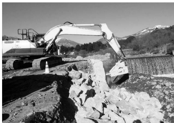
写真-10 とりこわし作業状況
