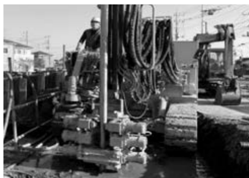
写真－14 二重管ダブルパッカー工法 削孔作業状況
