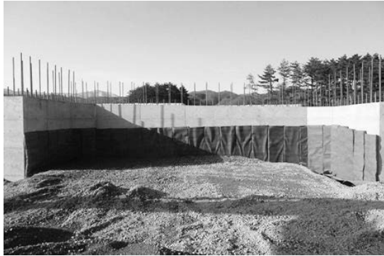
写真-3 排水材設置作業終了後全景(1)
