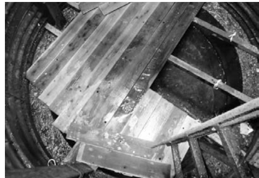
写真-23 足場設置・撤去作業状況
