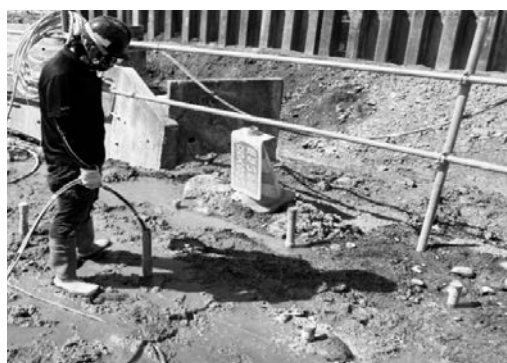
写真－15 二重管ダブルパッカー工法 注入作業状況
