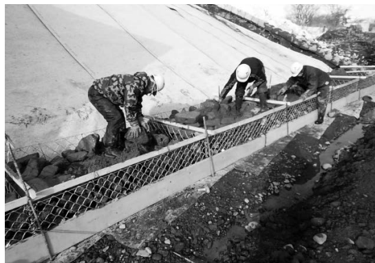
写真-19 補強材設置作業状況
