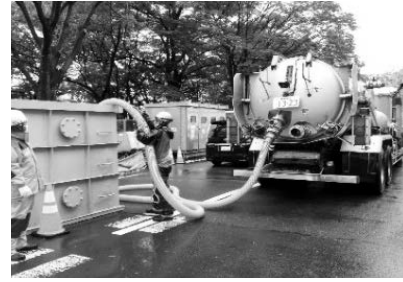
写真-6 吸入作業状況
