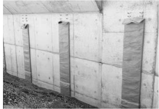
写真-4 排水材設置作業終了後全景(2)
