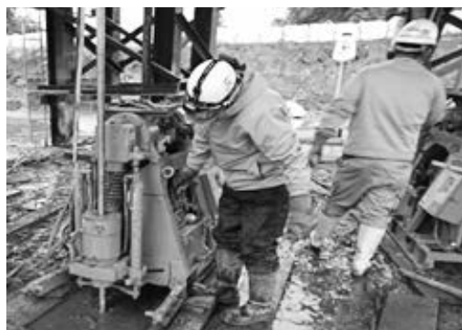
写真－13 二重管ストレーナ工法（複相）施工状況
