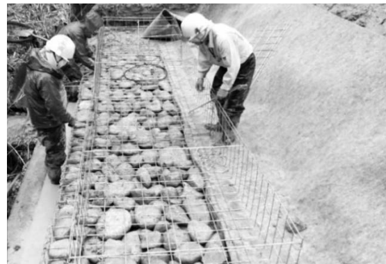
写真-18 かご組立・据付け作業状況
