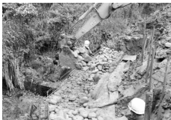
写真-20 詰石作業状況
