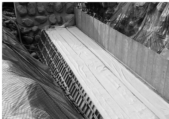
写真-9 コンクリート養生作業状況
