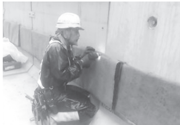
写真-1 排水材設置作業状況（コンクリート釘）
