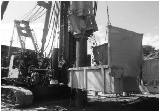
写真-16 杭打作業状況
