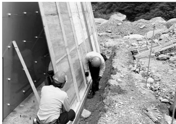
写真-7 型枠組立作業状況
