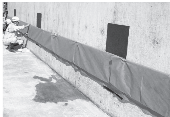
写真-2 排水材設置作業状況（接着剤）
