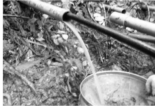
写真-22 孔内洗浄作業状況 (井外作業)
