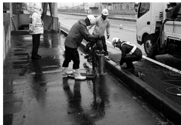
写真-12 削孔作業状況
