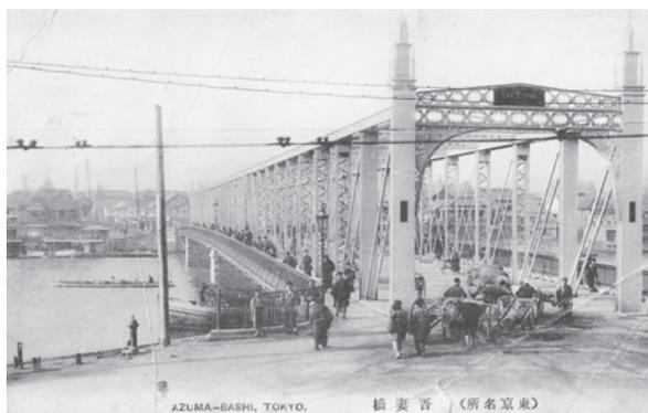
写真-1 錬鉄製のプラットトラス橋に架け替えられた吾妻橋
