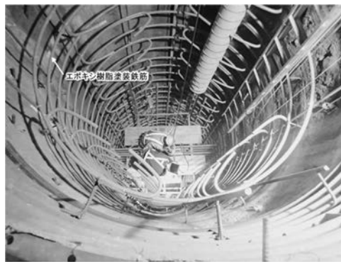
写真－3 RC 円柱支保工鉄筋組立状況
