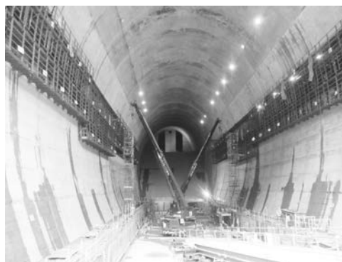
写真－2 減勢池部側壁スライドフォームの設置
