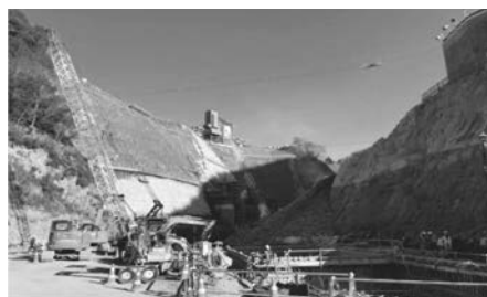
写真－13 令和3年度の立野ダム工事現場状況
