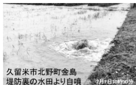
写真－3 筑後川堤防裏の漏水状況
