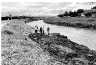
写真－6 筑後川支川 巨瀬川 右岸 9K 050
