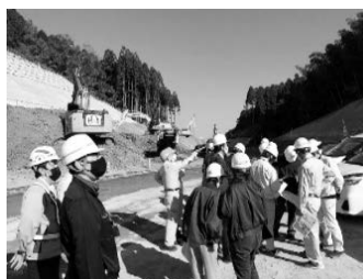
写真－16 九州中央道の切土・法面現場
