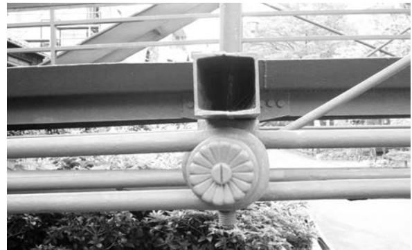
写真-6 八幡橋の菊の御紋の飾り
