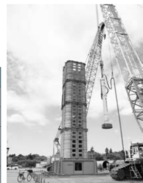
写真-5 大型の騒音防止装置
