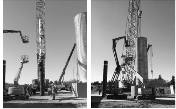
写真-1 初号機の防音性能確認試験 （左：装置なし，右：装置あり）
