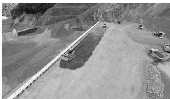
写真-3 ソイルセメント自動化施工状況
