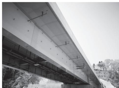
写真－6 高性能床版排水パイプ採用例
